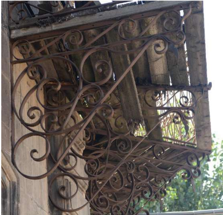
Նկար 24. Գամերի միջոցով ամրակցված պատշգամբի նեցուկներ: 19 դարի երկրորդ կես:
